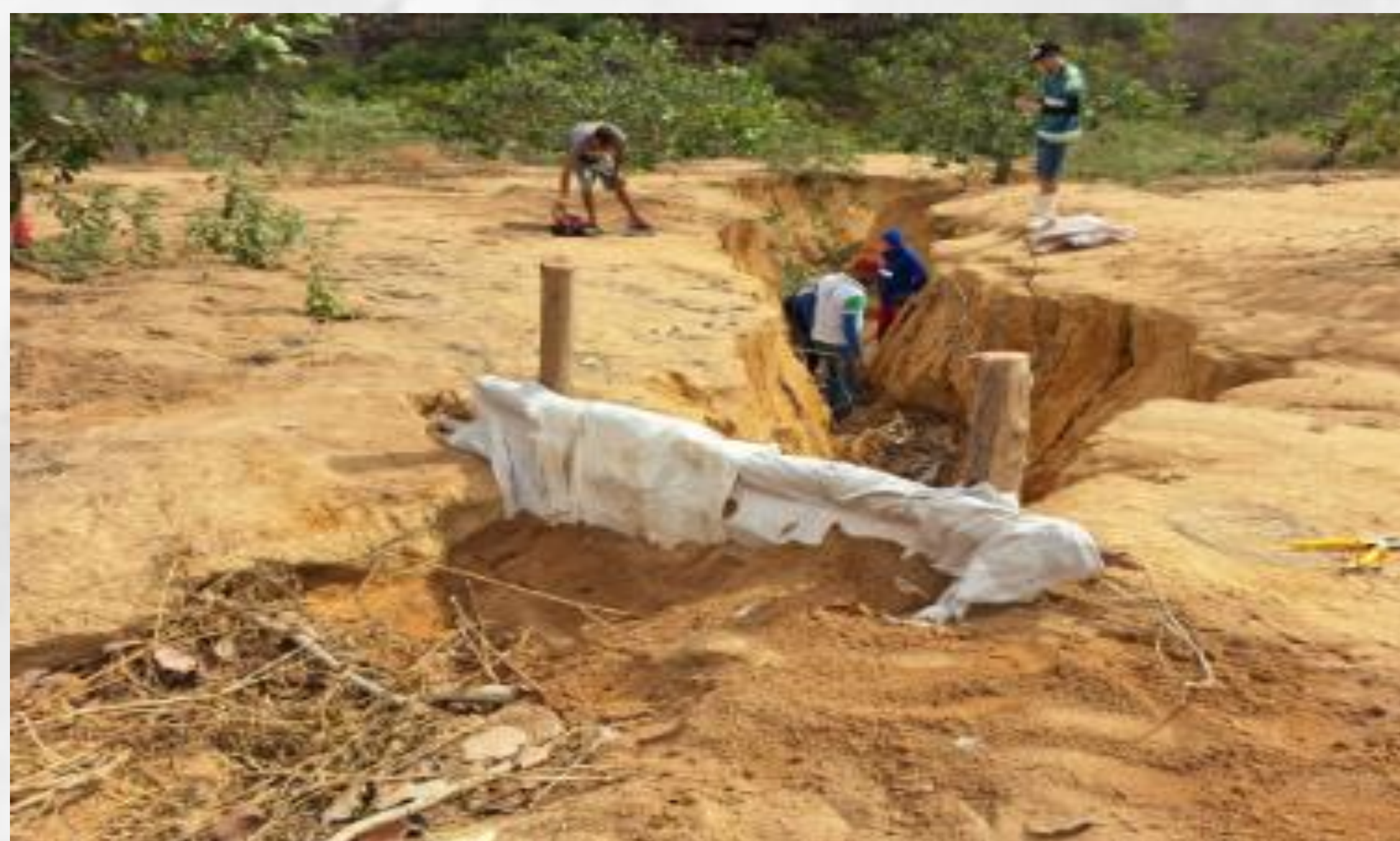
Figura 2 – Contenção de voçorocas com uso de paliçadas Fonte:Freitas (2023).
