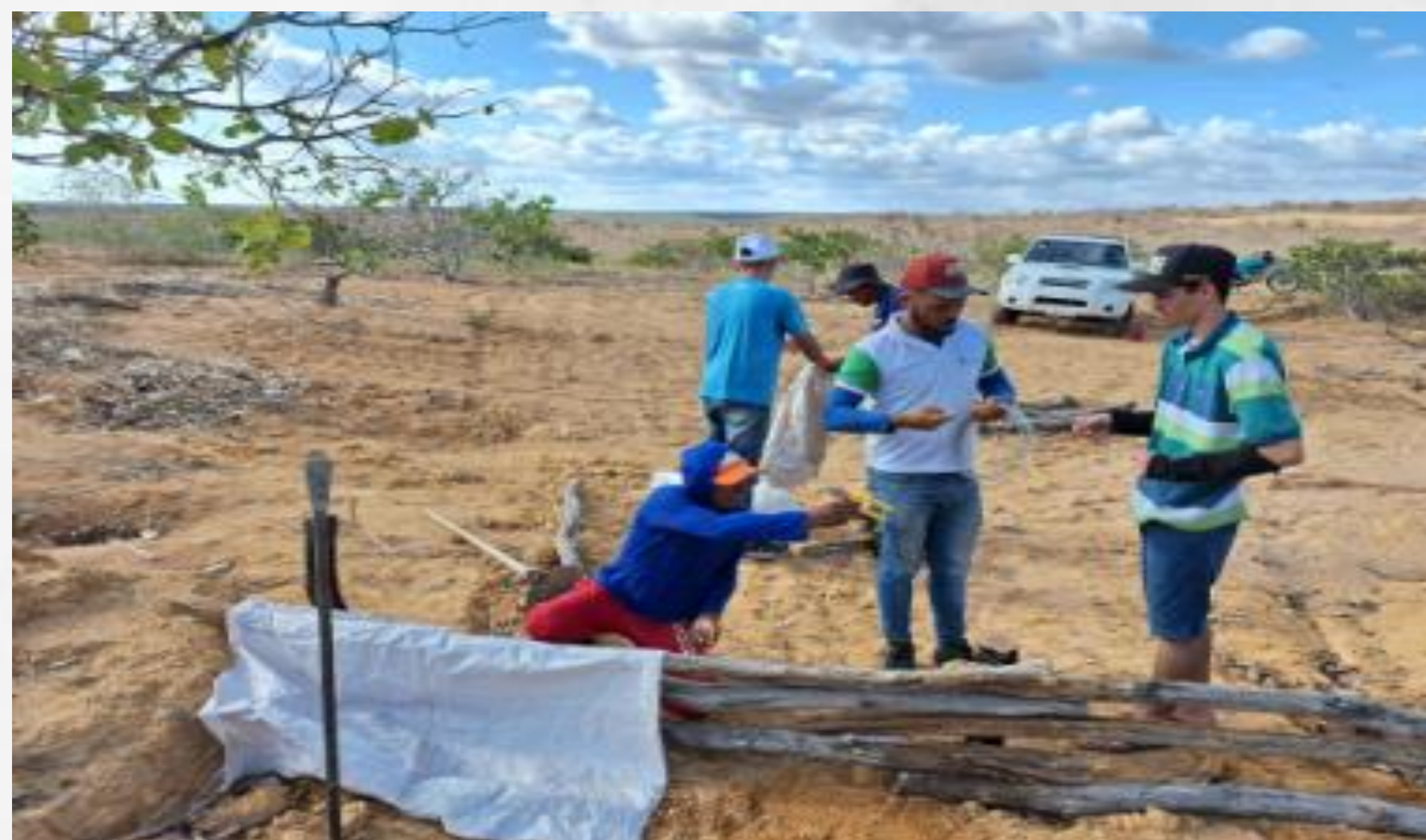
Figura 3 – Contenção de erosão laminar Fonte: Freitas (2023).
